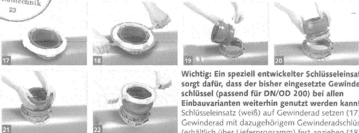
**Wichtig: Ein speziell entwickelter Schlüsseleinsatz sorgt dafür, dass der bisher eingesetzte Gewinnerschlüssel (passend für DN/OD 200) bei allen Einbauvarianten weiterhin genutzt werden kann!**
