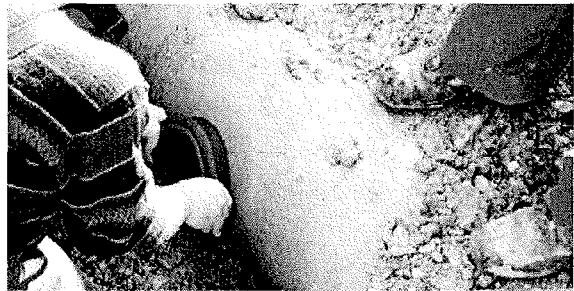
AWADOCK-Anschlussdichtung in die Bohrung einführen
