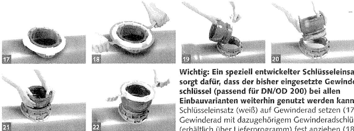
**Wichtig: Ein speziell entwickelter Schlüsseleinsatz sorgt dafür, dass der bisher eingesetzte Gewinderadschlüssel (passend für DN/OD 200) bei allen Einbauvarianten weiterhin genutzt werden kann!**
