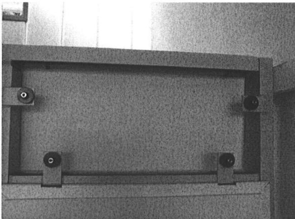
**Bild 3: Restliche Punkthalter anschrauben**
