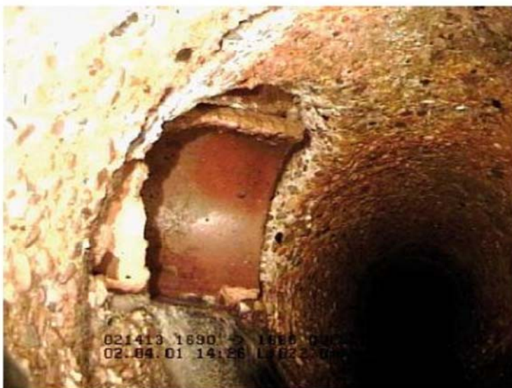
Foto einer Schadstelle
