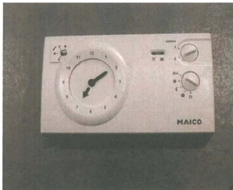
Raumluftsteuerung "RLS 2F" des zentralen Lüftungsgerätes mit Wärmerückgewinnung vom Typ "aeronom WR 600"
