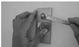
Bei der Befestigung der Wandanschlusskonsolen sind, je nach Art des Mauerwerks, die entsprechenden Befestigungsmittel nach Herstellerangaben einzusetzen.\*
