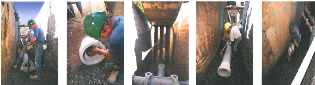
FABEKUN-Rohre und Formstücke mit Hebezeugen, die ein gleichmäßiges und feines Heben und Senken erlauben, in den Rohrgraben ablassen. Die Vorschrift der DIN EN 1610 Pkt. 8.4 ist unbedingt zu beachten.
