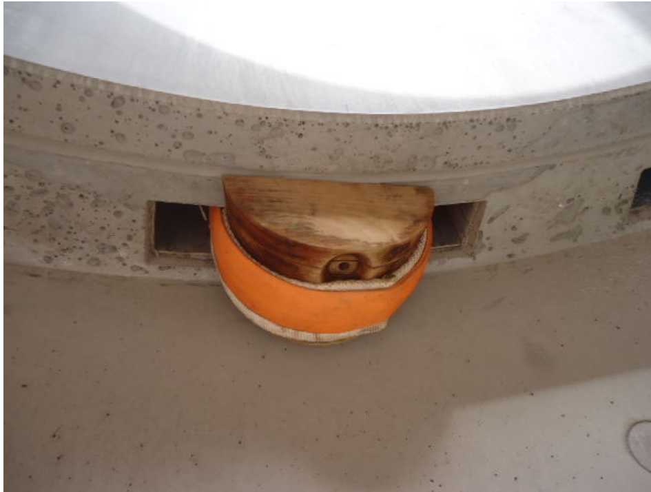
Bild 8: Beispiel für die Befestigung eines Schlupfs um den Holzkeil an der Unterkante des Adapters
