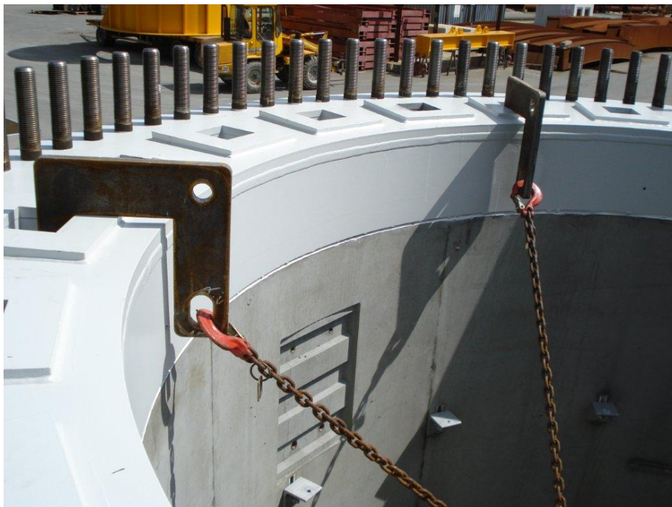
Bild 6: Beispiel für die Befestigung des Adapters während des Transportes
