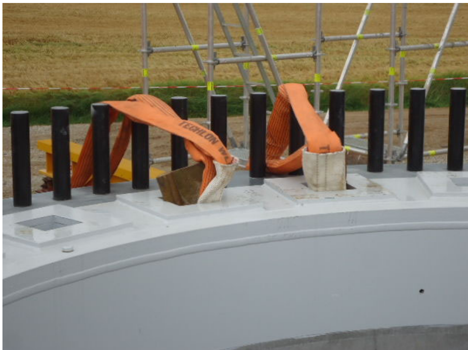
Bild 9: Oberkante des Adapters mit durchgeführtem Schlupf
