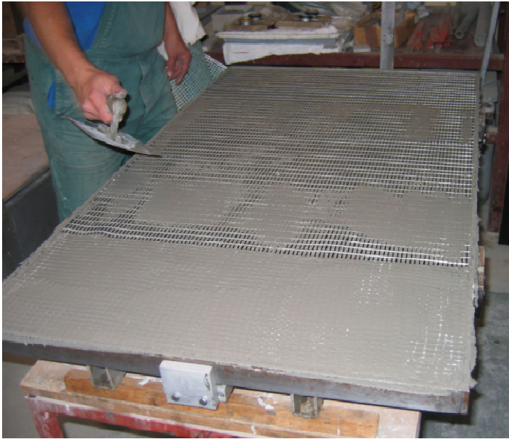
Bild 1: Herstellung der Textilbetonplatte im Handlaminierverfahren
