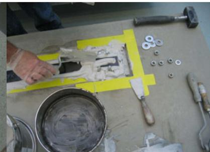
Die Lamelle wird fachgerecht verklebt. Die Endbereiche werden mit Klebstoff beschichtet. Die Abstandhalter werden unter bzw. auf die Lamelle gelegt
