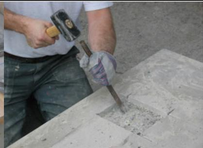
Entfernen des Betons im Bereich der Aussparung;
