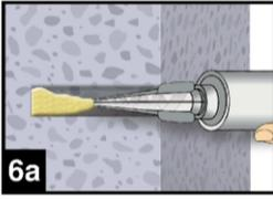
6. Gereinigtes Bohrloch vom Bohrlochgrund her ca. zu 2/3 mit Verbundmörtel befüllen. Langsames Zurückziehen des Statikmischers aus dem Bohrloch verhindert die Bildung von Lufteinschlüssen. Für Setztiefen größer 190 mm passende Mischerverlängerung verwenden.
