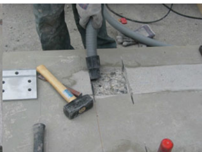
Entfernen des Betons im Bereich der Aussparung;
