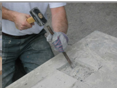
Entfernen des Betons im Bereich der Aussparung;
