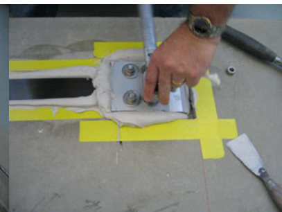
Die 4 Halteschrauben werden von Hand angezogen
