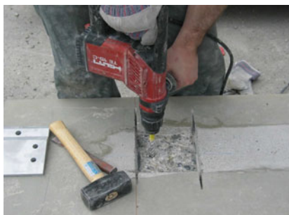
Bohren und versetzen des fischer Ankers; das Gewinde muss 55 mm überstehen
