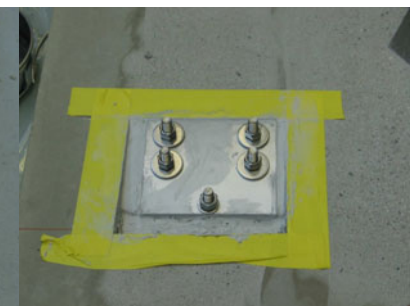
Ist eine Vielzahl an Endverankerungen zu montieren, kann die Grundplatte in die Aussparung gepresst und die Schrauben leicht angezogen werden
