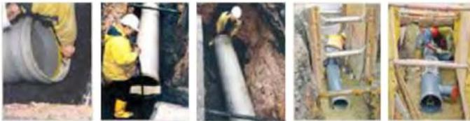
Für die Verlegung der Rohre gelten die DIN EN 1610 sowie das ATV-Arbeitsblatt A139. Bei der Erstellung von Rohrgraben und Verbau ist ergänzend die DIN 4124 zu beachten. Die Einbauparameter müssen den Erfordernissen der statischen Berechnung entsprechen (s. Grafik).
