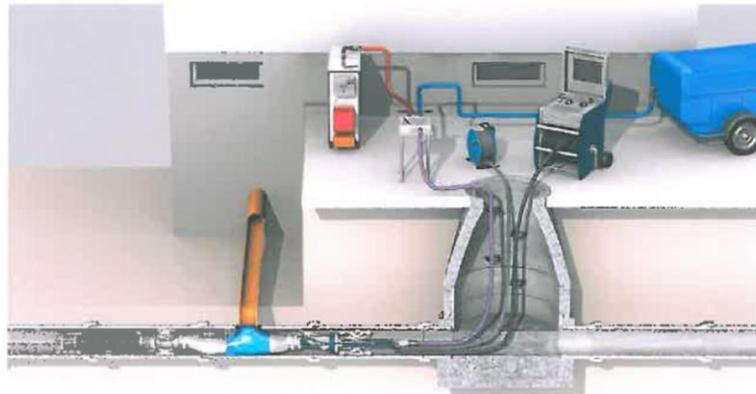
DrainMth-Packer zurückziehen, bis sich der DrainMth-Packerkorb in den Seitenanschluss hinein schiebt und dadurch einrastet.
