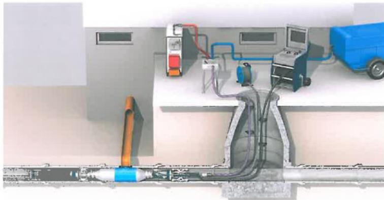
Am Dampfmischlanzengestell bzw. an der Dampf-Telemetrie-Anlage den Hebel „Luft/Air“ soweit öffnen, dass sich der Hauptteil des Packers füllt und deutlich an die Rohrwand presst.
