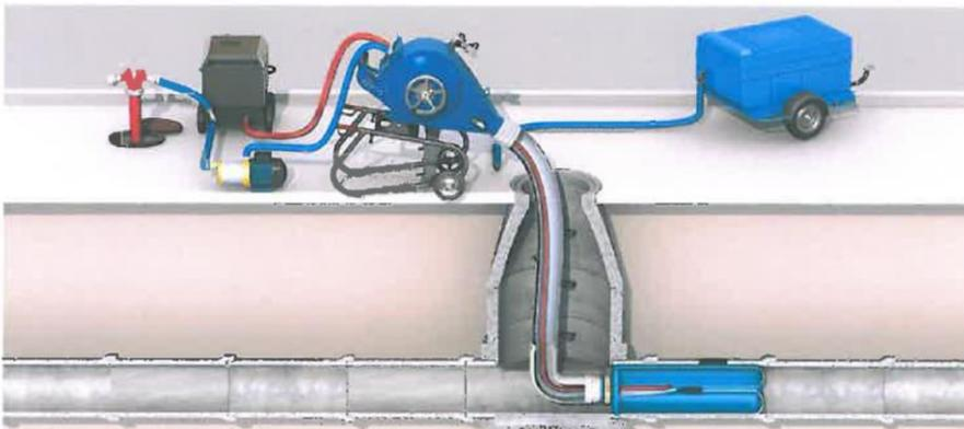
2. Inversion des Schlauchliners, Heizschlauch wird mit inversiert.
