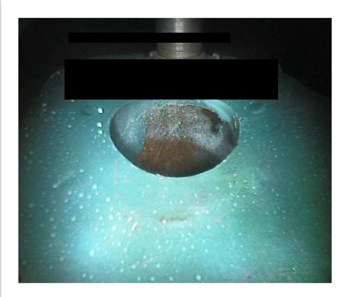
Spachtel- und Verpressverfahren mit der Bezeichnung WILLPOX® RS zur Sanierung erdverlegter schadhafter Abwasserleitungen im Nennweitenbereich DN 250 bis DN 800 mit Kaltaushärtung und DN 200 bis DN 600 mit Warmaushärtung
