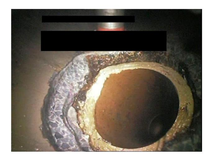
Spachtel- und Verpressverfahren mit der Bezeichnung WILLPOX® RS zur Sanierung erdverlegter schadhafter Abwasserleitungen im Nennweitenbereich DN 250 bis DN 800 mit Kaltaushärtung und DN 200 bis DN 600 mit Warmaushärtung
