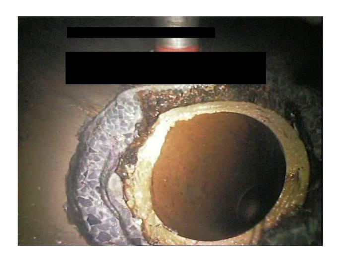
Spachtel- und Verpressverfahren mit der Bezeichnung WILLPOX® RS zur Sanierung erdverlegter schadhafter Abwasserleitungen im Nennweitenbereich DN 250 bis DN 800 mit Kaltaushärtung und DN 200 bis DN 600 mit Warmaushärtung
