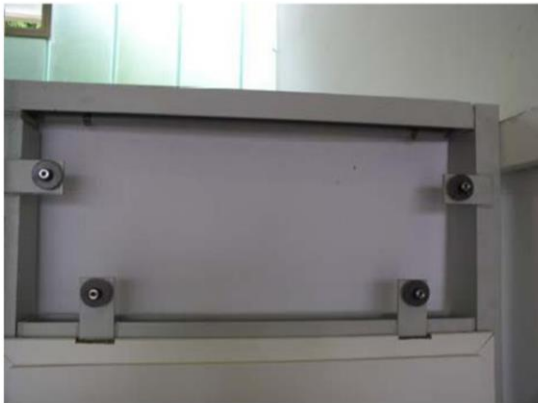
Bild 3: Restliche Punkthalter anschrauben
