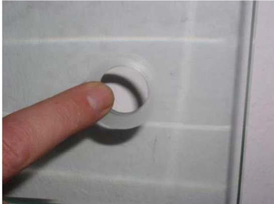
Bild 5: Senkbohrung prüfen
