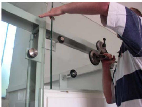
(Bild 9: Montagealternative) Einsetzen der Glasscheibe mit vormontierten Senkkopfhaltern
