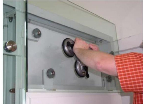
Bild 6: Glasscheibe einsetzen
