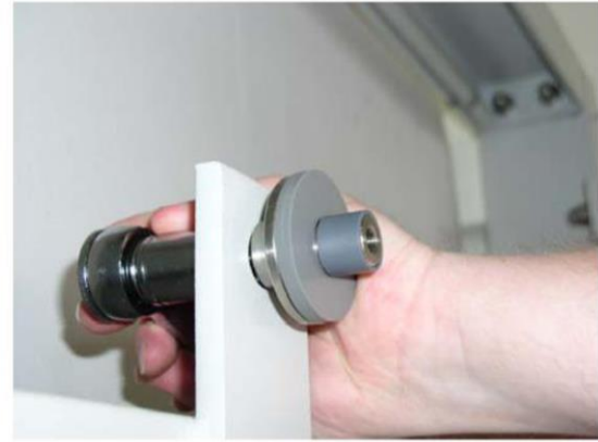
Bild 2: Punkthalterunterteil aufschrauben
