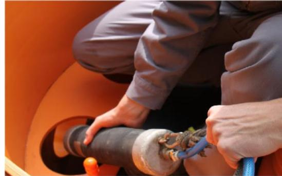
Einbringen der Rohrabsperblase in den Ablaufstutzen des HydroClean AF
