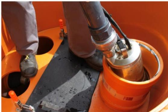
Einführen der Pumpe in die Zulaufkammer
