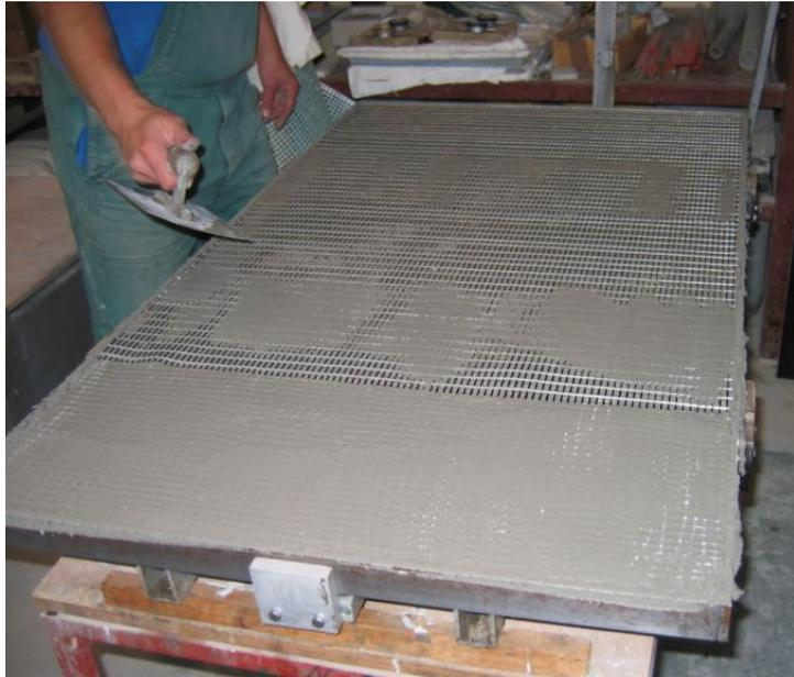
Bild 1: Herstellung der Textilbetonplatte im Handlaminierverfahren
