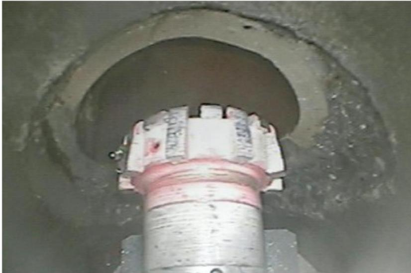
Sanierung von erdverlegten, schadhaften Abwasserleitungen mit dem Spachtel- und Verpress-Epoxidharzsystem mit der Bezeichnung „WILLPOX® SP 1:1 im Nennweitenbereich DN 200 bis DN 800
