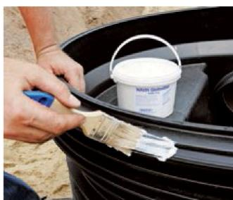
7. Bevor das Schachtrrohr auf den Schachtboden aufgesetzt werden kann, sind die Dichtelemente nochmals auf ihren korrekten Sitz zu überprüfen. Alle Dichtungen und Dichtflächen sind dann gleichmäßig und umlaufend mit Gleitmittel zu versehen.
