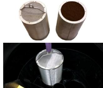
12. Die Substratkartuschen sind zu öffnen (Abschrauben der Flügelschrauben am Deckel) und das Ferrosorp Plus Substrat in die Kartusche einzufüllen (30 kg je Kartusche, 2 Säcke a` 15 kg). Nach dem Schließen der Substratkartusche ist die Dichtung zu kontrollieren und die Kartuschen in den Certaro DN 1000 Substrat einzusetzen.
