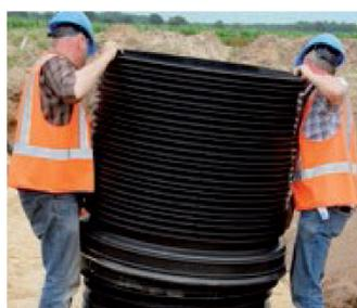
8. Danach ist das Schachtrrohr gemäß den Planungsvorgaben auszurichten und ohne Verkanten auf den Schachtboden aufzusetzen. Bei einer Montageunterstützung mit hydraulischem Gerät ist zum Schutz der Schachtbauerteile ein Kantholz oder eine entsprechende.
