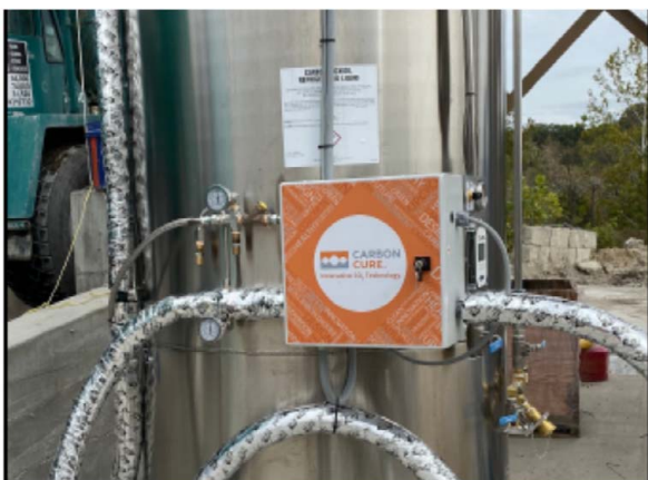
Abb.1: Montage der Dosiereinheit
