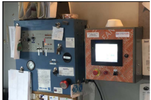
Abb.2: Installation der Kontrolleinheit in einer Leitwarte
