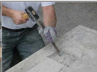
Entfernen des Betons im Bereich der Aussparung;
