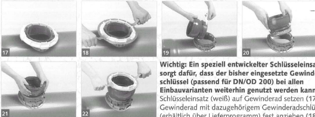
**Wichtig: Ein speziell entwickelter Schlüsseinsatz sorgt dafür, dass der bisher eingesetzte Gewinderadschlüssel (passend für DN/OD 200) bei allen Einbauvarianten weiterhin genutzt werden kann!**
