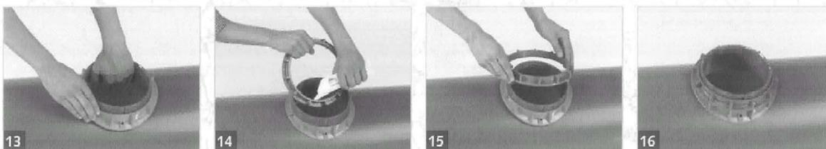
**Wichtig: Unterteil in Bohröffnung so zentrieren, dass umlaufend ein gleichmäßiger Ringspalt entsteht (13).** Graues Gewinderad innen mit dazugehörigem Gleitmittel bestreichen (14). Graues Gewinderad so aufsetzen, dass es sich nicht verkantet und leicht verschrauben lässt (15). Mit einer Hand Anschlussunterteil hochziehen, um es an den Innenradius des Hauptrohres anzupassen. Mit anderer Hand graues Gewinderad handfest verschrauben (16).
