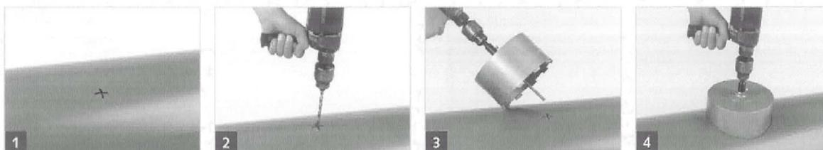
Einbaustelle auf dem Kunststoffrohr – hier CONNEX®-Kanalrohr – mit geeignetem Stift markieren (1). Schnittstelle mit Spiralbohrer 8 mm vorbohren (2). Führungsstift der Bohrkronen in diese Bohrung einführen (3). Kernbohrung zentrisch im 90°-Winkel zur Rohrachse erstellen. Durchmesser der Bohrung 162 bzw. 200 mm ± 1 mm (4). **Unbedingt auf absplittungsfreie Ausführung achten.**
