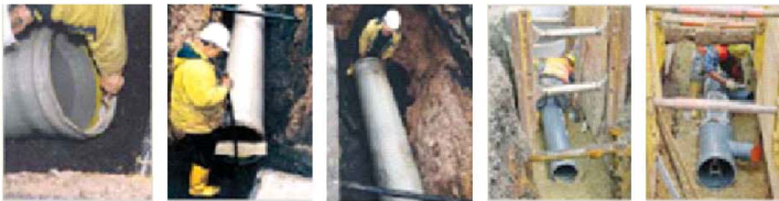
a: Untere Bettungsschicht b: Obere Bettungsschicht c: Rohrabdeckung
