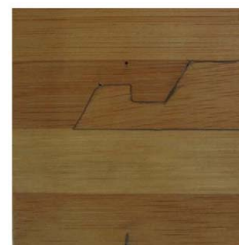
Bild 3: Hakenverbindung zur Verlängerung einzelner Streifen
