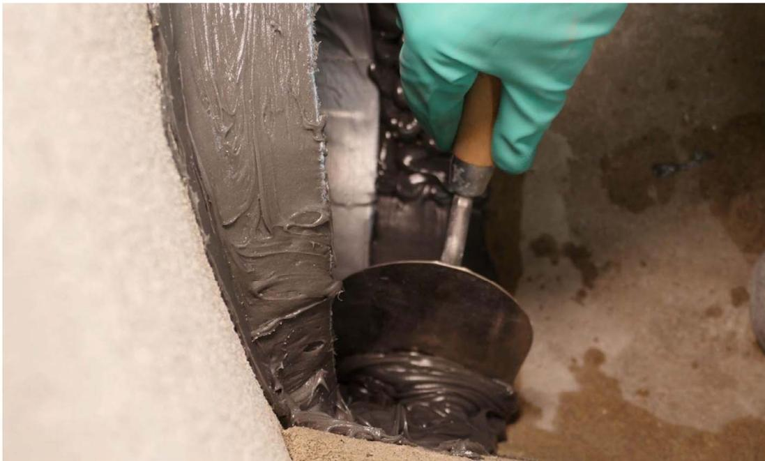
**Bauprodukte und deren Verwendung zur Ausführung von Schlauchlineranbindungen an Schachtbauwerke mit dem Polyurethan-Harzsystem mit der Bezeichnung „Konudur Flexfit“ bzw. „Konudur Flexfit CS“**
