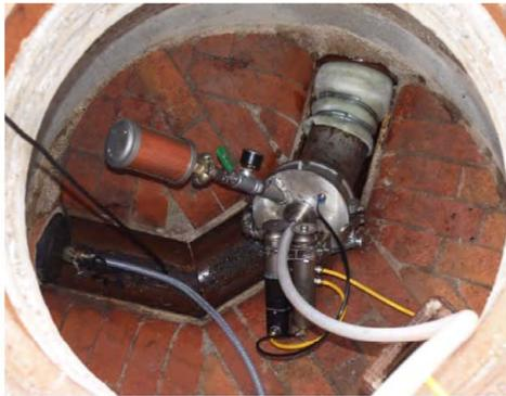
Montage der Schleuse am Bogen im Schacht
