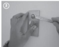
Bei der Befestigung der Wandanschlusskonsolen\* sind, je nach Art des Mauerwerks, die entsprechenden Befestigungsmittel nach Herstellerangaben einzusetzen. (3)
