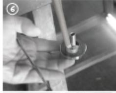
Die Punkthalter sind für die Anbindung an die Wandanschlusskonsole und Zugstange auszurichten (Stellung der Laschen). Alle Gewindestifte und Schrauben sind im gewindewirksamen Teil mit Schraubensicherungsmasse mittelfest entsprechend der Herstellerangabe zu sichern. Glasscheibe mit den eingebauten Punkthaltern und Laschen in die unteren Wandanschlusskonsolen eingehängt und mit Bolzen und Sicherungsringen gesichert. (5)
