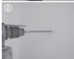
Die Bohrungen sind mit Bohrwerkzeugen für die jeweiligen Befestigungsmittel, z.B. Sicherheitsanker, Verbundanker oder Injektionsdübel - abhängig von der Art des Mauerwerks - (gem. Herstellerangaben) zu setzen. (2)
