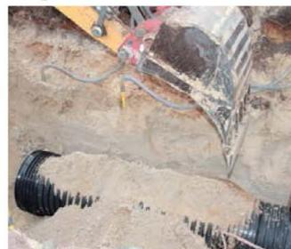
11. Die Anlage ist gemäß DIN EN 1610 in Lagen von max. 30 cm zu verfüllen und mit entsprechendem Verdichtungsgerät zu verdichten. Die Seitenverfüllung ist insbesondere im Kämpferbereich besonders sorgfältig mit leichtem Verdichtungsgerät durchzuführen.
