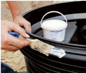
7. Bevor das Schachtrohr auf den Schachtboden aufgesetzt werden kann, sind die Dichtelemente nochmals auf ihren korrekten Sitz zu überprüfen. Alle Dichtungen und Dichtflächen sind dann gleichmäßig und umlaufend mit Gleitmittel zu versehen.
