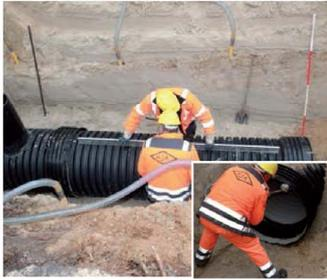
5. Das Sedimentationsrohr ist mithilfe einer Wasserwaage auszurichten und zu fixieren und der Ablaufschacht entsprechend dem Erweiterungsmodul zu montieren.
