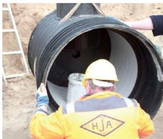
2. Die Bauteile sind mithilfe von Traggurten an den Halteösen in die Baugrube zu lassen und zu positionieren. Aus Sicherheitsgründen dürfen die Bauteile nur einzeln und ungefüllt transportiert werden.
