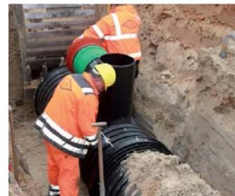
4. Mithilfe eines Baggers wird das Erweiterungsmodul nun in die Baugrube gelassen. Zum Verbinden schieben Sie nun das Erweiterungsmodul mit der Muffe vorsichtig auf das Spitzende des Zulaufmoduls.
