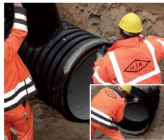
3. Zum Verbinden von Zulauf- und Erweiterungsmodul ist auf dem Spitzende des Zulaufmoduls der Dichtring zwischen erstem und zweitem Wellental einzulegen und Gleitmittel gleichmäßig aufzutragen.
