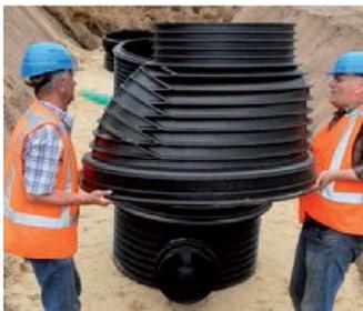
10. Der Schachtkonus ist analog zu den Schachtröhren auszurichten und ohne Verkanten aufzusetzen. Bei Bedarf kann der Schachtkonus um bis zu 80 mm gekürzt werden.
