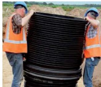
8. Danach ist das Schachtrohr gemäß den Planungsvorgaben auszurichten und ohne Verkanten auf den Schachtboden aufzusetzen. Bei einer Montageunterstützung mit hydraulischem Gerät ist zum Schutz der Schachtbauerteile ein Kantholz oder eine entsprechende.
