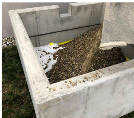
Bodenvlies und Kiesbasis
