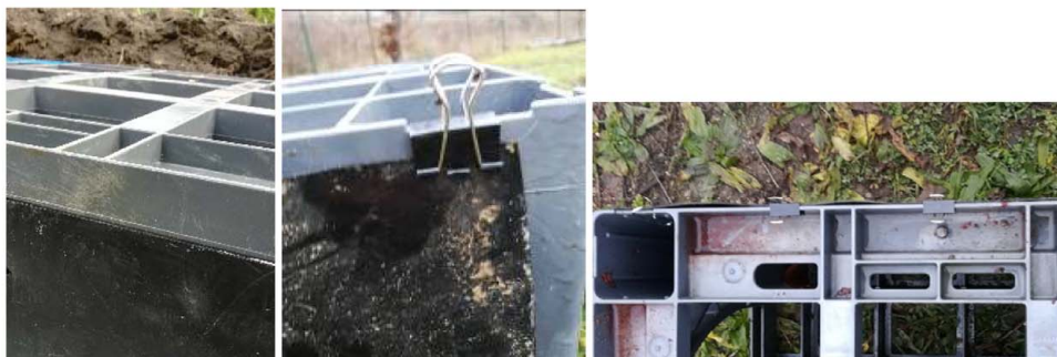
Abbildung 4: Montage der seitlichen Folie der Klammern
