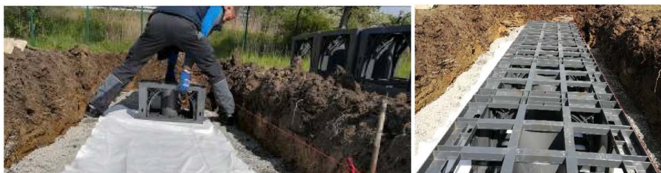
Abbildung 2: Verlegung D-Rainclean Boxen
