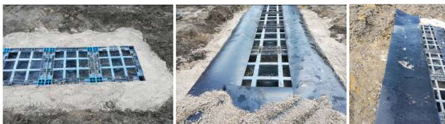
Abbildung 8: Verlegung der oberen Folienschicht
