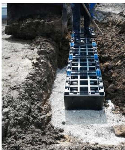
Abbildung 5: Verfüllung der Baugrube
