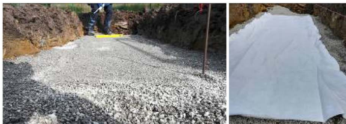
Abbildung 1: Erstellung der Ausgleichsschicht & Verlegung von Vlies
