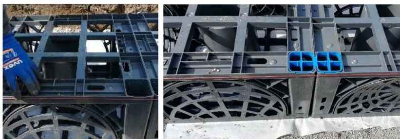
Abbildung 3: Montage Seitenplatten & Verbinder
