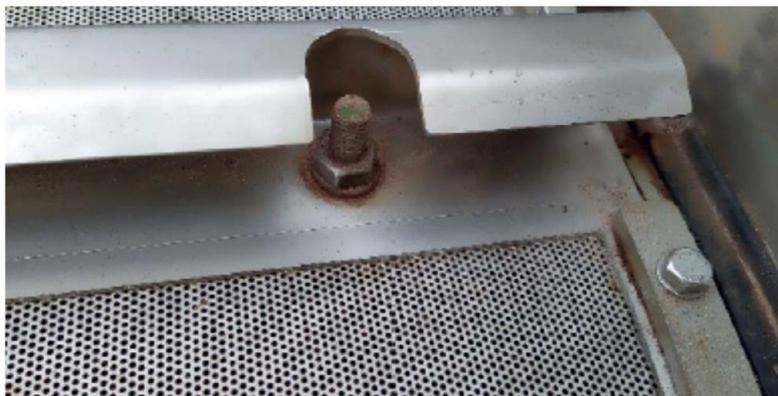
Abb. 3: Sechskantmutter und Griffmulde
