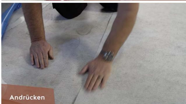
**Verklebung der Kopfstöße/Zuschnitte mittels des doppelseitigen Klebebandes TP10 und
