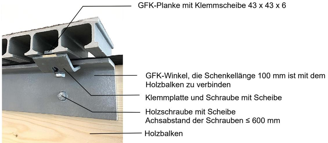
Befestigung mittels Klemmscheibe 43 x 43 x 6 (s. Anlage 2.8), GFK-Winkelprofil (s. Anlage 2.10), Sechskantschraube M10 mit Stahlscheibe (s. Abschnitt 2.1.2.7) und Sechskant-Holzschraube M10 mit Stahlscheibe (s. Abschnitt 2.1.2.6)
