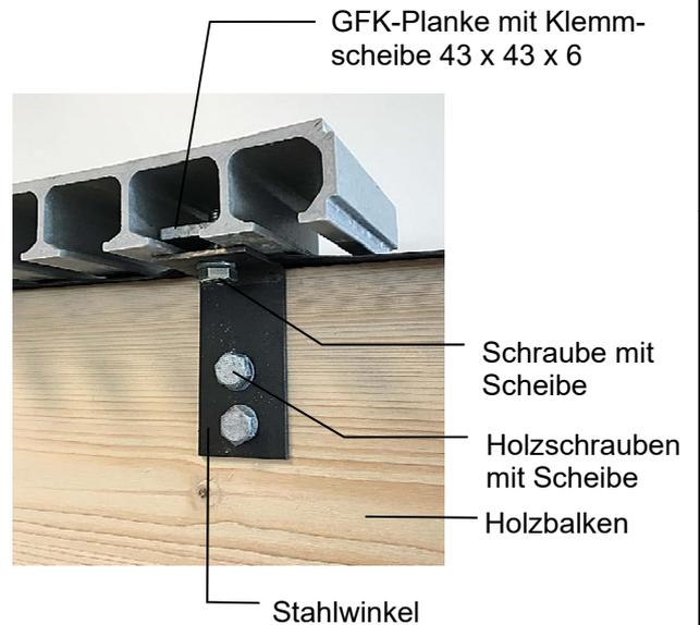
Der Stahlwinkel ist mit zwei Sechskant-Holzschrauben M10, L ≥ 50 mm an die Holzunterkonstruktion zu befestigen.
