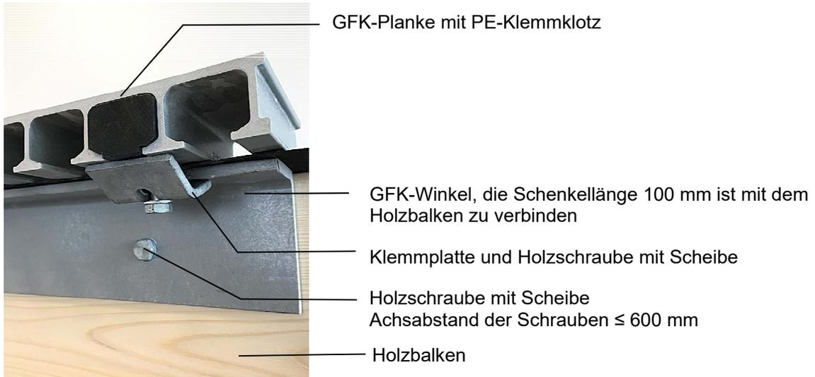
Befestigung mittels PE-Klemmklotz (s. Anlage 2.6), GFK-Winkelprofil (s. Anlage 2.10) und
