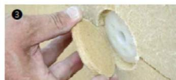
Die Dübellöcher werden mit dem INTHERMO HFD-Bohrtool gebohrt. In das Bohrtool wird der mitgelieferte Spiralbohrer für Holz eingesetzt. Es werden in einem Arbeitsgang die Ausfräsung für den Tellerdübel erstellt sowie das Loch in der Platte (1).
