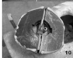
Außenverschalung mit Sanierungsstutzen in das Montagewerkzeug einbringen und in den roten Führungsstopfen einführen (8).
