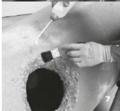
Der Bereich muss frei von Staub, Öl, Fetten oder sonstigen trennend wirkenden Stoffen sein. Säubern Sie die betreffende Stelle mit dem mitgelieferten Reiniger (7), Schutzhandschuhe und Schutzbrille tragen. Der graue Stutzen darf **nicht** mit dem Reiniger gesäubert werden (7a).
