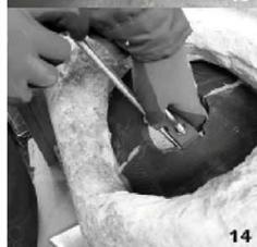
Drehen Sie nun das Kontereisen mit der Innenschalung so, dass sich das Kontereisen in Rohrlängsachse befindet (13). Dabei muss die mit der Dichtmasse versehene Seite der klappbaren Innenschalung an der Innenwand vom Rohr anliegen.
