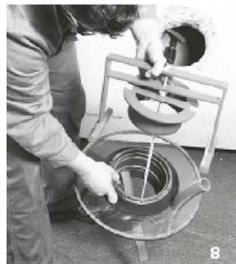
Der Sanierungsstutzen DN/OD 160 ist für Ausbrüche bis max. 260 mm Durchmesser geeignet, jedoch muss der Ausbruch mindestens so groß sein, dass der Anschluss von 200 mm  $\varnothing$  in die Öffnung passt.
