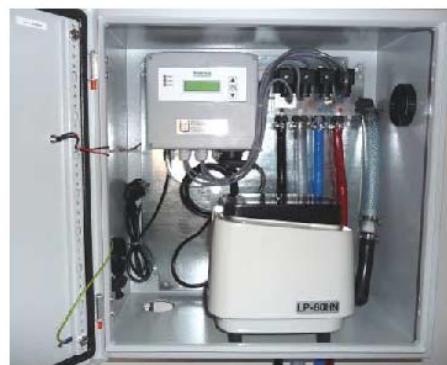
Schaltschrank mit Steuerungseinheit und Kolbenverdichter (Beispielbild)
