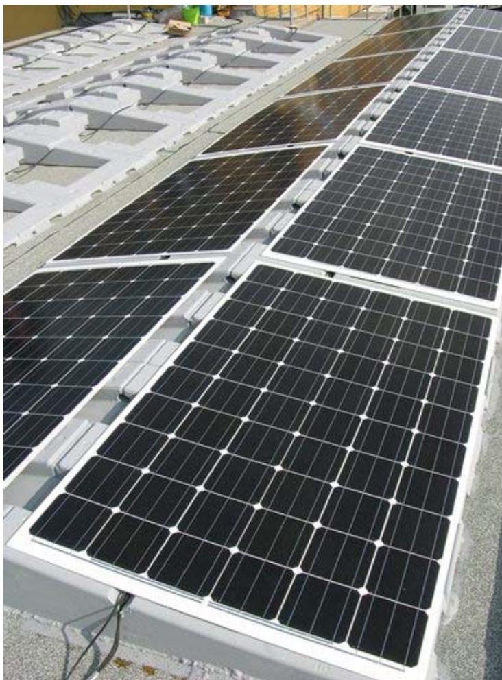
SOFLATECH PV-EPS-Trägersystem zur Befestigung von Solaranlagen auf Dachabdichtungsbahnen
