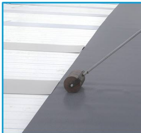
Anrollen der "Monarplan GF V (EM)" Bahnen mit Hilfe der "BMI InnoGrip Andrückrolle"
