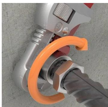
Verwenden eines Standardschlüssels zum Anziehen der Muffe. Für Bewehrungsstäbe mit  $\varnothing \geq 25$  mm ist eine Mindesthebellänge von 0,80 m zu verwenden.
