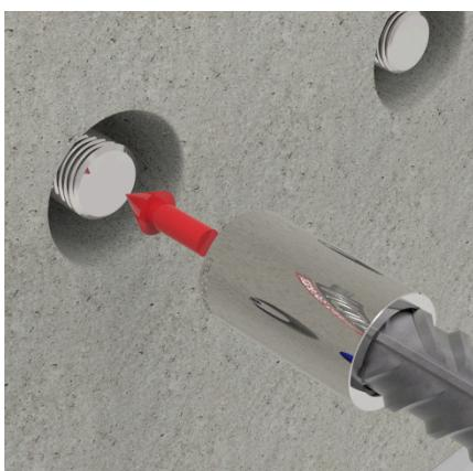
Prüfen, ob die Muffe vollständig auf dem Bewehrungsstab der 2. Phase eingedreht ist.
