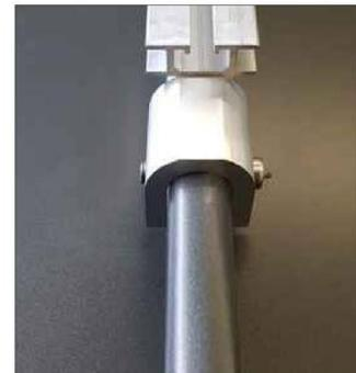
3. Schrauben der U-Klemme werden mit 18 Nm angezogen.
