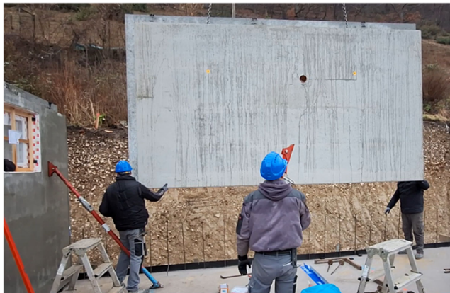
Bild A16: Wandelement mit 2 eingebauten HWD-PLUS zur bauseitigen Montage
