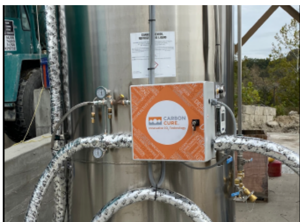
Abb. 1: Montage der Dosiereinheit
