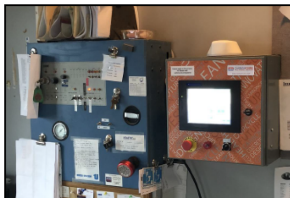
Abb. 2: Installation der Kontrolleinheit in einer Leitwarte
