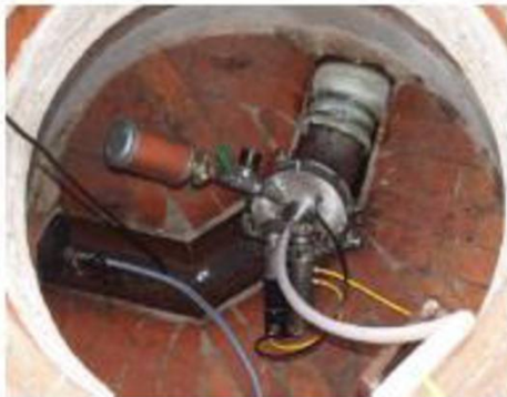
Montage der Schleuse direkt am Bogen im Schacht
