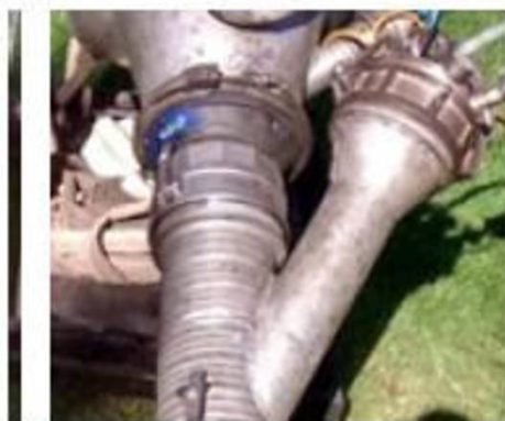
Montage der Schleuse an der Seitenzuführung
