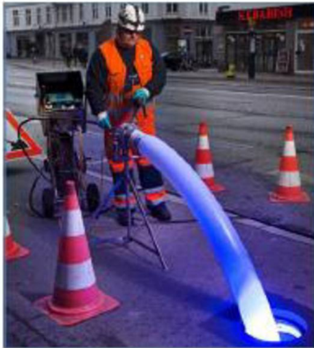
Montage der Schleuse am Verlängerungsschlauch
