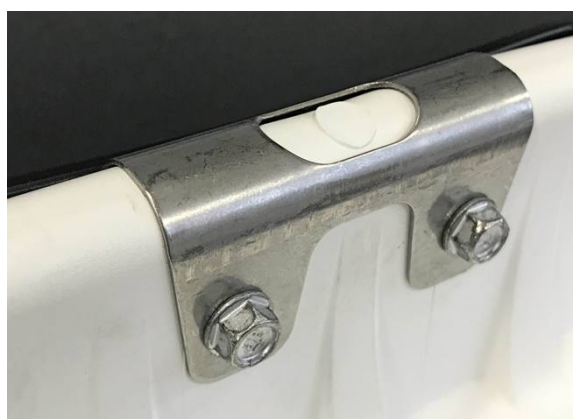
Abbildung A5-4: Verschraubung der Metallklammer
