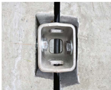
Abbildung 2: Agrar-RubberElast nach der Montage mit dem BT-Spannschloss
